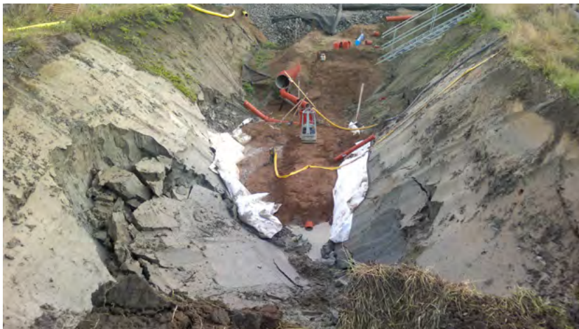
Figur 43. Skred på grund av för brant schaktslännt i kombination med höga portryck i siltskikt i leran orsakat av ihärdigt regnande.
