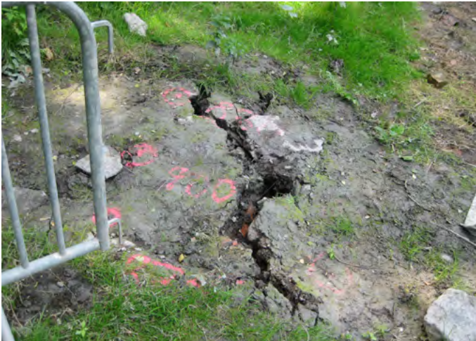
Fig. 85. Sprickor på grund av markrörelser.
