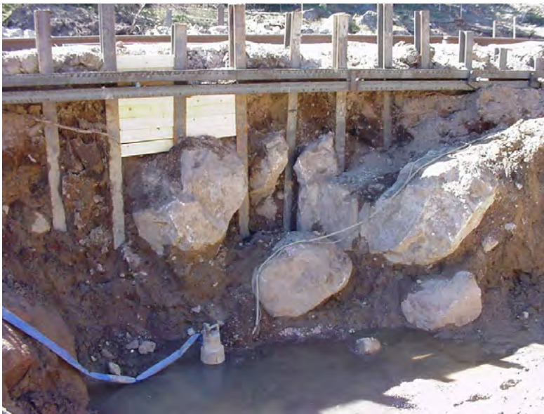
Fig. 77. Glesspont (berlinerspont) under utförande.
