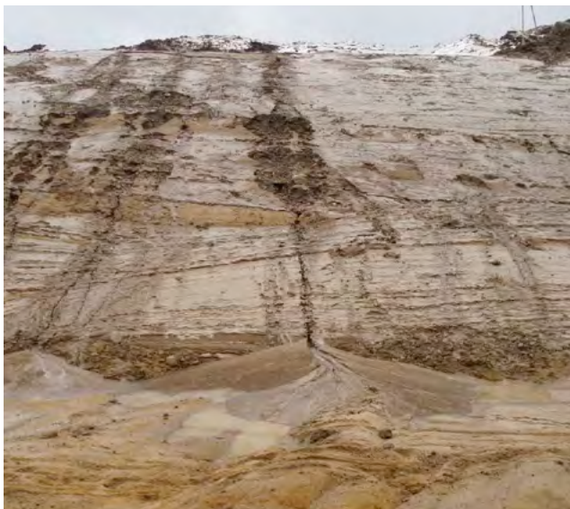
Fig. 7. Vissa jordar är känsliga för erosion av rinnande vatten i eller på slänten. I denna schaktslänt syns spår av erosion. Erosion kan leda till större ras speciellt om erosionen sker i släntfot.
