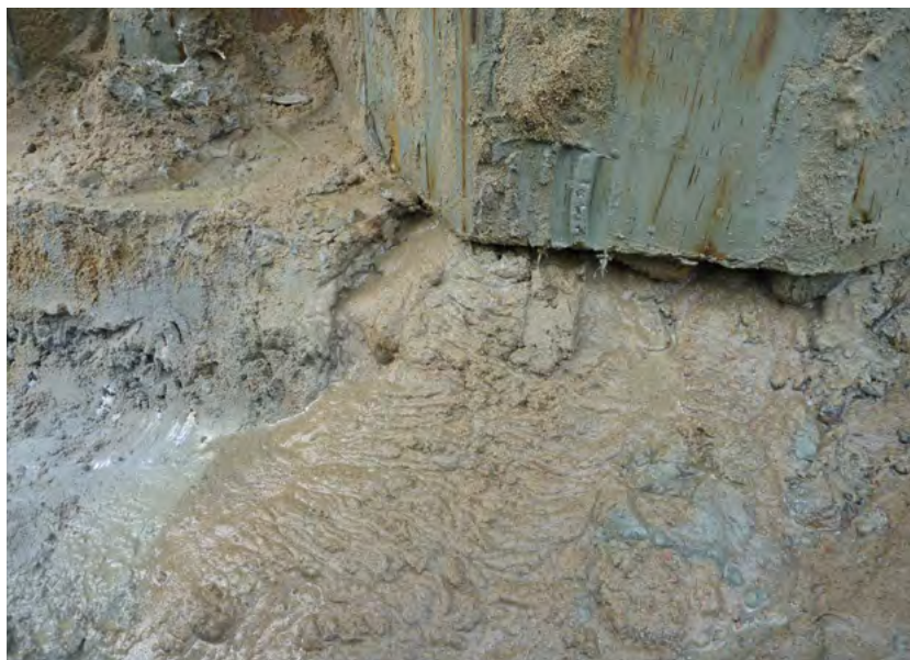
Fig. 51. Inströmmande sand och silt under spontfot. Sand- och siltlagret överlagras av tät lera.
