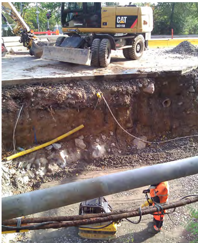
Fig. 8. Denna schakt rasade inte men vibrationer i närheten av schaktslänter kan orsaka ras, speciellt om slänterna är branta. I blockrika jordar finns även en risk för blockutfall.
