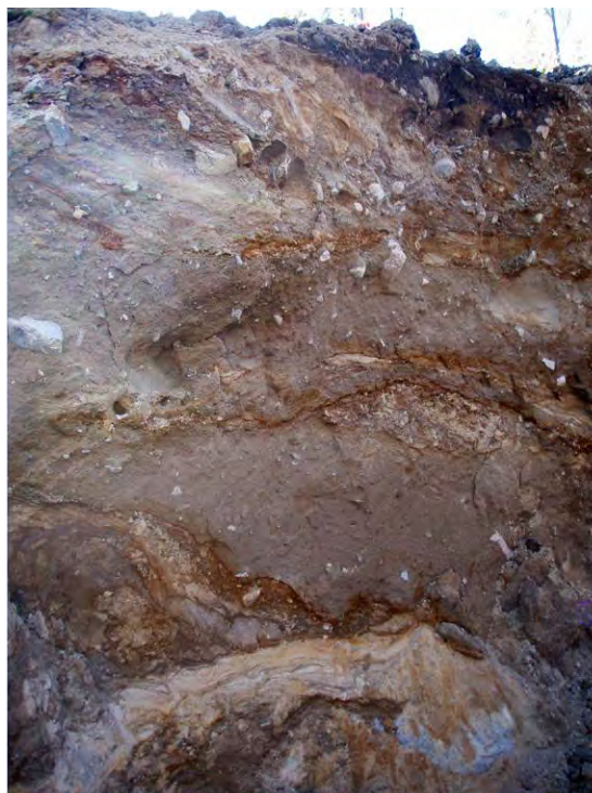
Fig. 70. I undre delen av fotografiet syns ett ljust lager med sand och grus inlagrat i siltiga partier av en morän. Sådana lager kan orsaka stabilitetsproblem.
