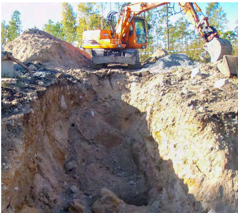
Fig. 4. När denna va-schakt rasade ledde det till att en person omkom. Raset orsakades av att man schaktade med för brant lutning, att man inte reagerade på att jordlagerförhållandena inte överensstämde med handlingarna och att schaktens stabilitet påverkades negativt av rådande väderlek som i detta fall var varmt och soligt vilket torkade ut jorden (schakten stod öppen länge).
