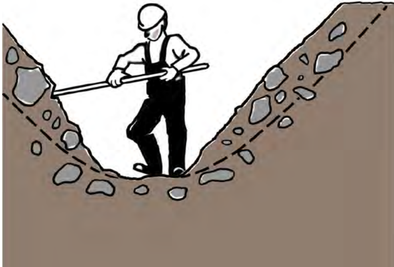
Fig. 27. Risk för att block faller ner i schakten.
