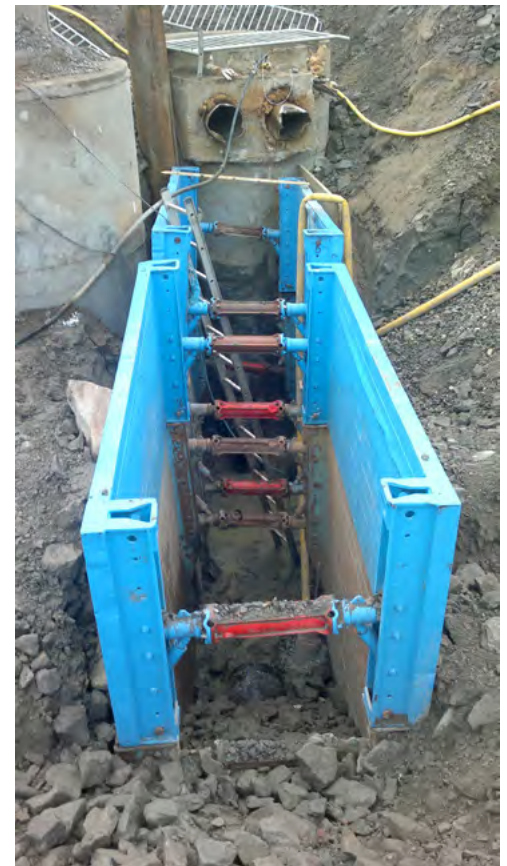
Fig. 78. Spontkassetter är förtillverkade spontväggar som lyfts och trycks ner i schakten.
