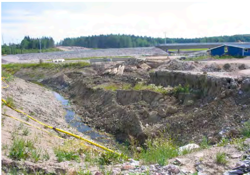
Fig. 3. Denna schakt rasade på grund av att för stor belastning (schaktmassor) lagts upp nära släntkrön. Val av rätt storlek på maskiner i kombination med gränser för var och hur nära schaktslätten som laster och maskiner får placeras är viktigt. Begränsningslinjer för minsta avstånd mellan last och schakt kan märkas ut med käppar eller avspärningar.
