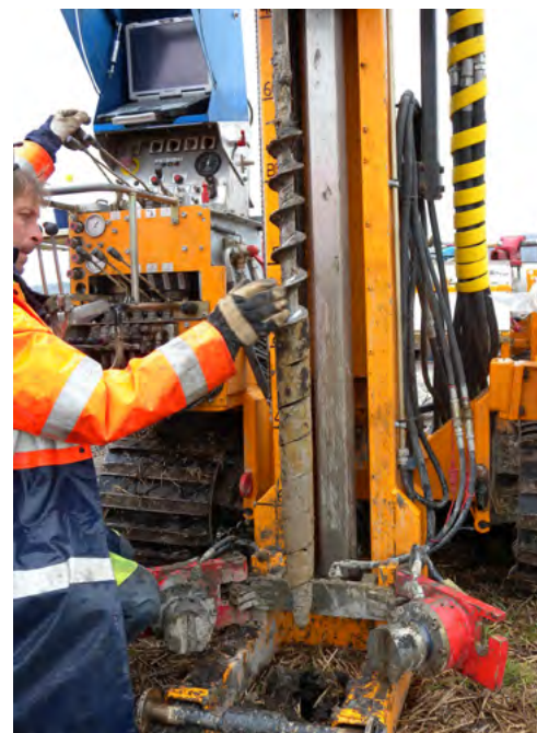
Fig. 35. Provtagning med skruvprovtagare.
