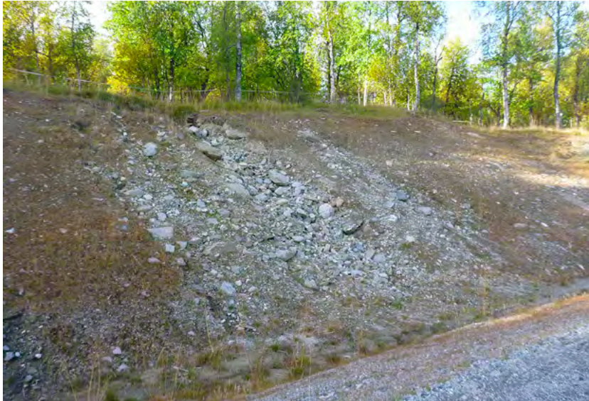
Fig. 52. Ytvattenerosion i vägslänt.
