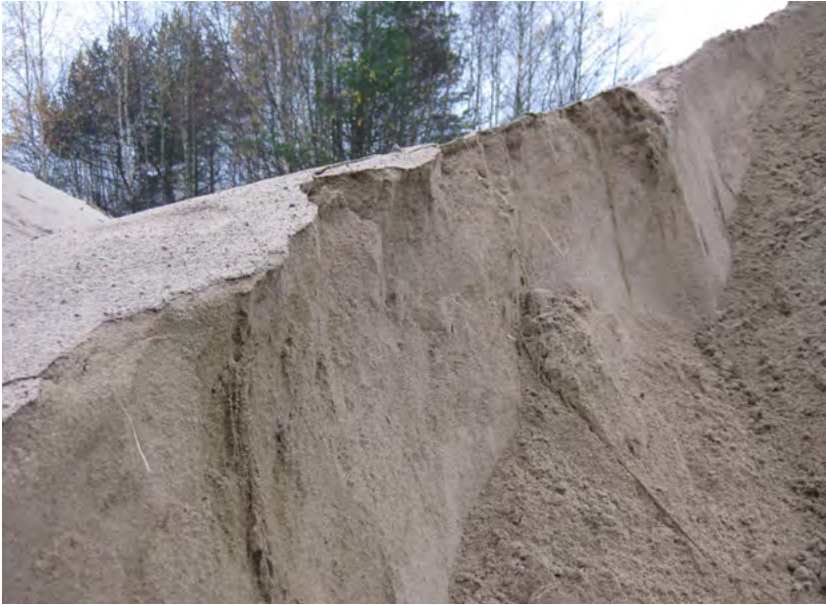
Fig. 66. Falsk kohesion möjliggör en mycket brant slänt i sand eller silt men vid uttorkning eller genomblötning kan den falska kohesionen försvinna och slänten rasa.
