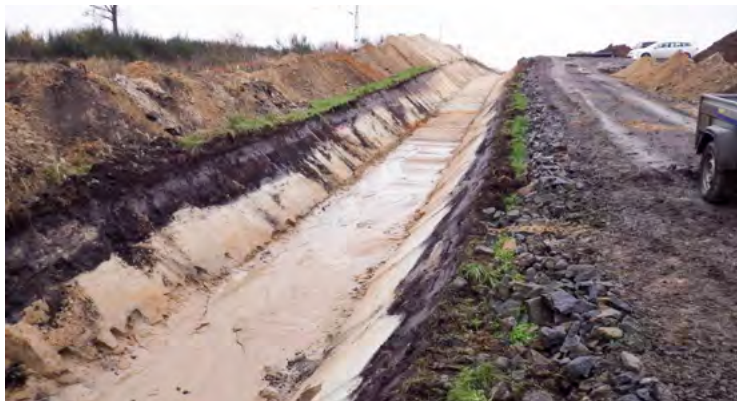
Fig. 62. Grundvattenerosion i sand.
