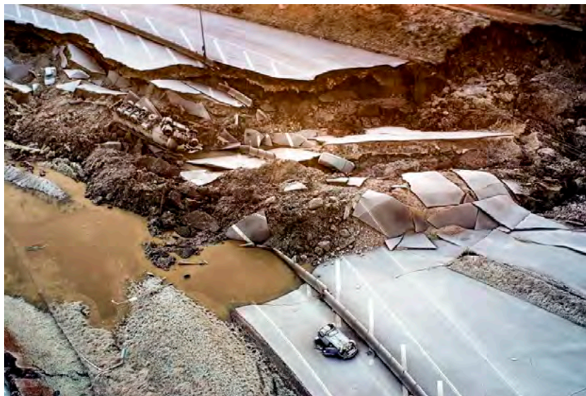
Fig. 44. Skred som orsakats av att totalstabiliteten var för låg.
