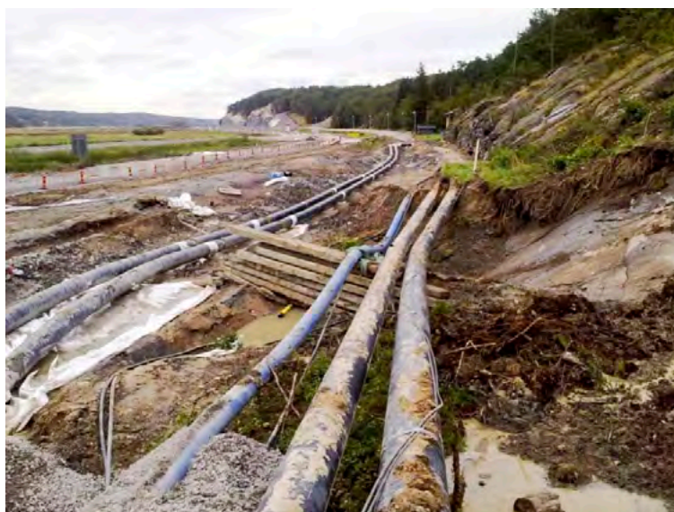
Fig. 10. Detta exempel visar att det vid ett inträffat skred gäller att göra rätt saker så att man inte förvärrar situationen. Vid schaktarbeten för en ny vattenledning gick ett litet skred. Skredet medförde att tidigare lagda fjärrvärmeledningar, som låg i närheten av de nya schaktarbetena, lyftes. Därefter schaktades de uppträngda jordmassorna bort. Denna åtgärd ledde till ytterligare ett skred, denna gång med större konsekvenser. Om man hade kontaktat en geotekniker före åtgärden skulle ytterligare skred kunnat förhindras.
