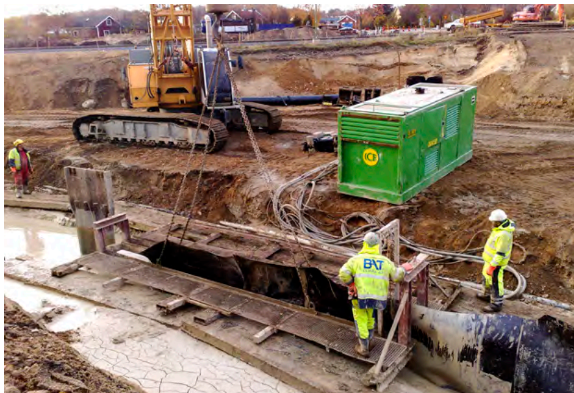
Fig. 41. Maskiner orsakar stora laster nära släntkrön.
