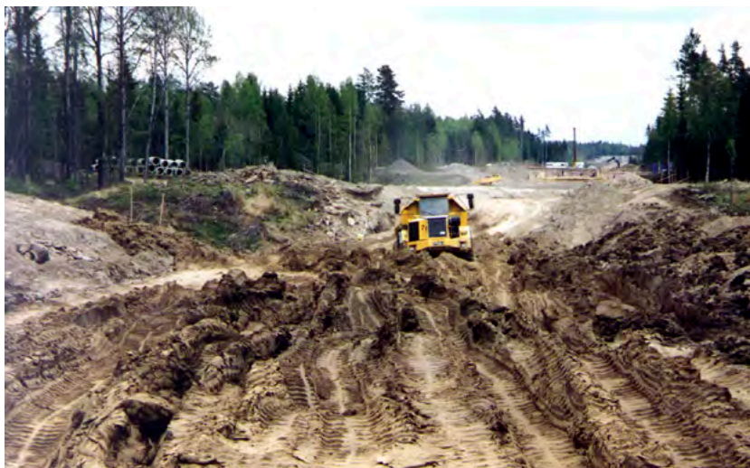
Fig. 19. Vid körning med tunga fordon över siltjordar kan silten övergå till en svårhanterlig massa.
