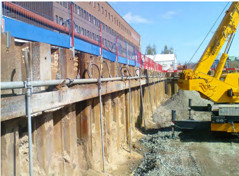
Fig. 58. Grundvattensänkning med well-point.
