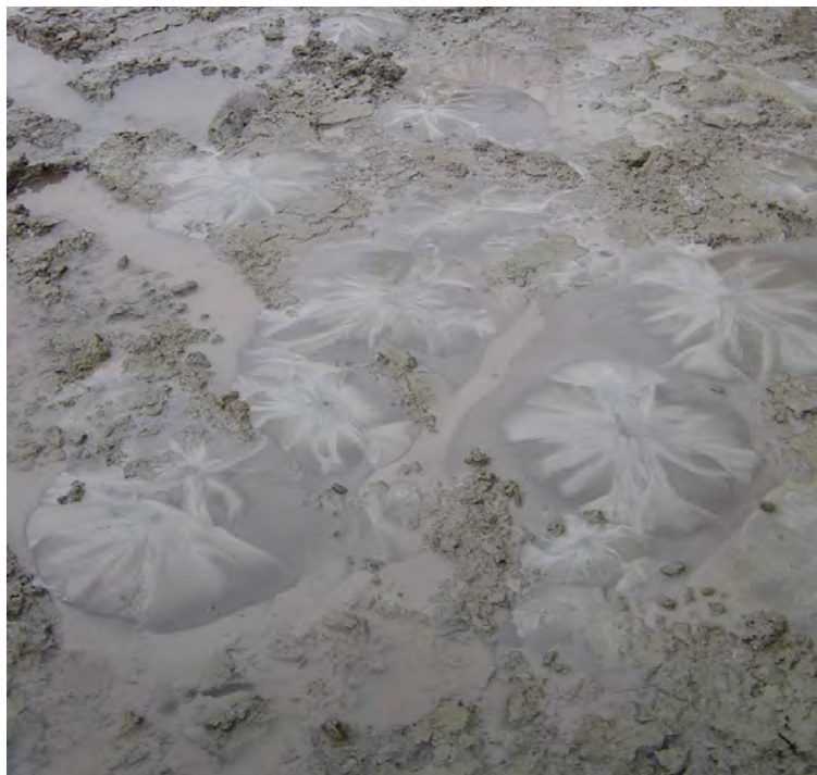
Fig. 9. Här visas en schaktbotten vars bärlighet försämrades betydligt då man inte hade kontroll på grundvattenflödet in under schakten. Grundvattenflöden kan dra med sig jordpartiklar ut ur jorden och orsaka piping (rörbildning) med låg bärlighet som följd.
