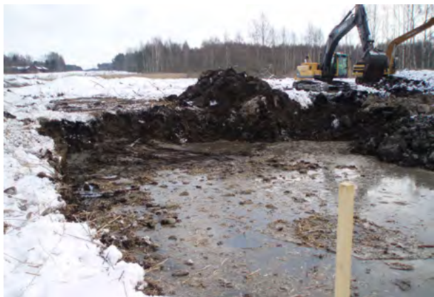
Fig. 31. Schaktning i torv.
