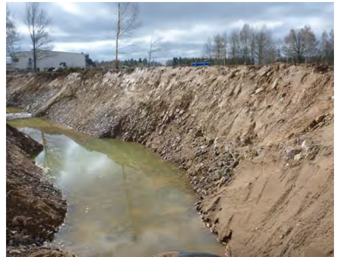
Fig. 88. Schakt till 4 m djup som saknar skydds- anordning (vilket är ett lagkrav).
