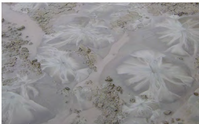
↑ Fig. 55. Kraterbildning (piping) i schaktbotten.
